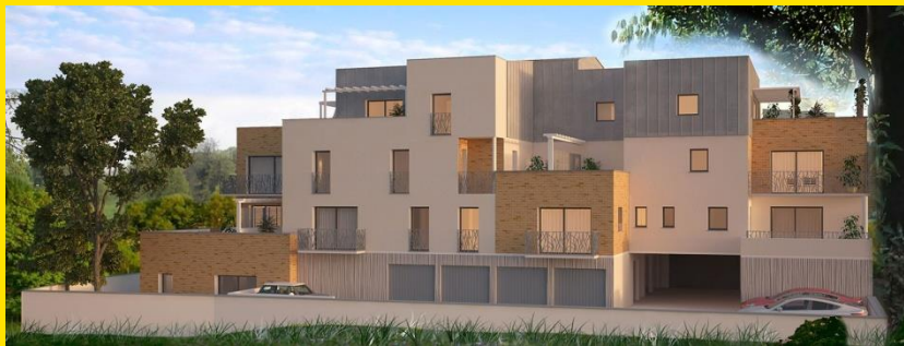
Projet de réalisation de bâtiments collectifs entièrement en béton recyclé pour Pierre et Territoires
