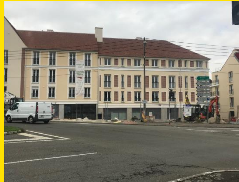
Réalisation des bétons extérieurs et VRD pour le groupe LEGENDRE
