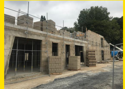
Réalisation des bétons de fondation d'une cantine scolaire pour ALM
