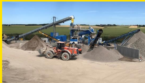
Machine de lavage
